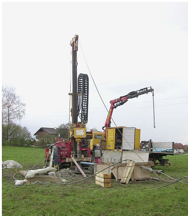
Errichtung eines Bohrbrunnens
